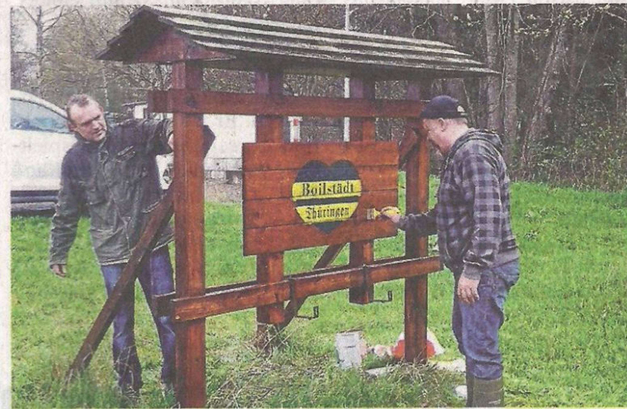
Das Willkommenschild am Ortseingang erhielt einen neuen Anstrich. Am Gebäude der Feuerwehr wurde ein Aufstellfläche gepflastert.
